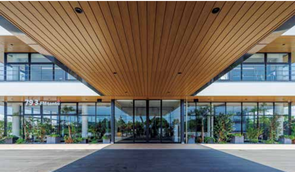
正面エントランスと大型キャノピー
